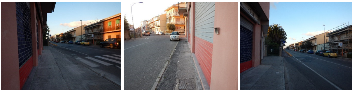
Figura 6 Viste dello stato di degrado dei marciapiedi e della pista ciclabile lungo via Casu
