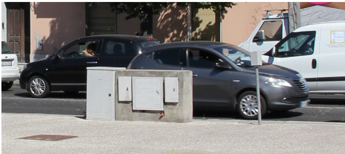
Quadri elettrici interferenti con il nuovo tracciato stradale
