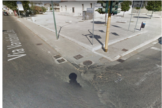
Pozzetti e caditoie interferenti con la futura rotonda in prossimità dell'Ex Foro Boario.
